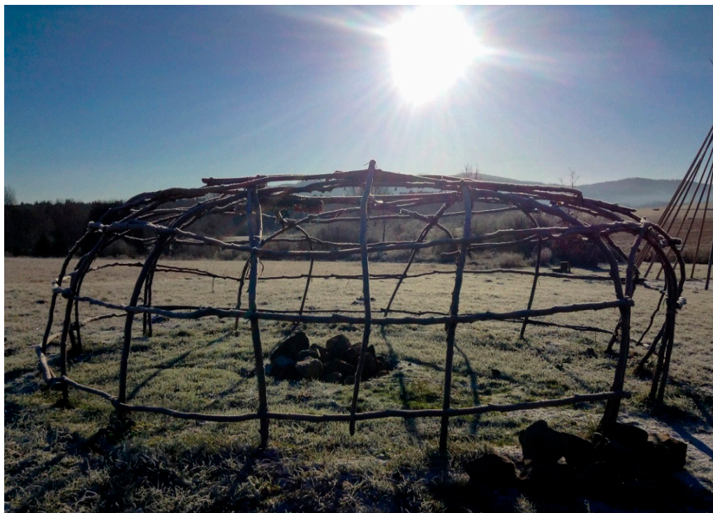
Obr. 14: Dřevěná konstrukce potní chýše (zdroj: vlastní zpracování)
