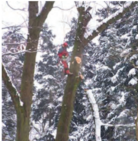
Řízený pád odřezané větve (vhodné při práci v blízkosti elektrovodů)
