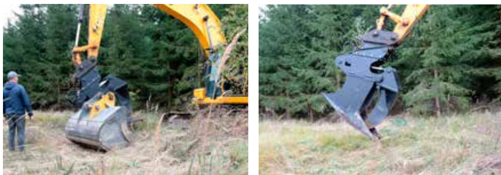
Obr. 14–15 Aplikace klučící hlavice na výložník bagru JCB. Odpojení bagrové lžice a montáž klučící hlavice a kontrola upevnění na koncovou část výložníku
