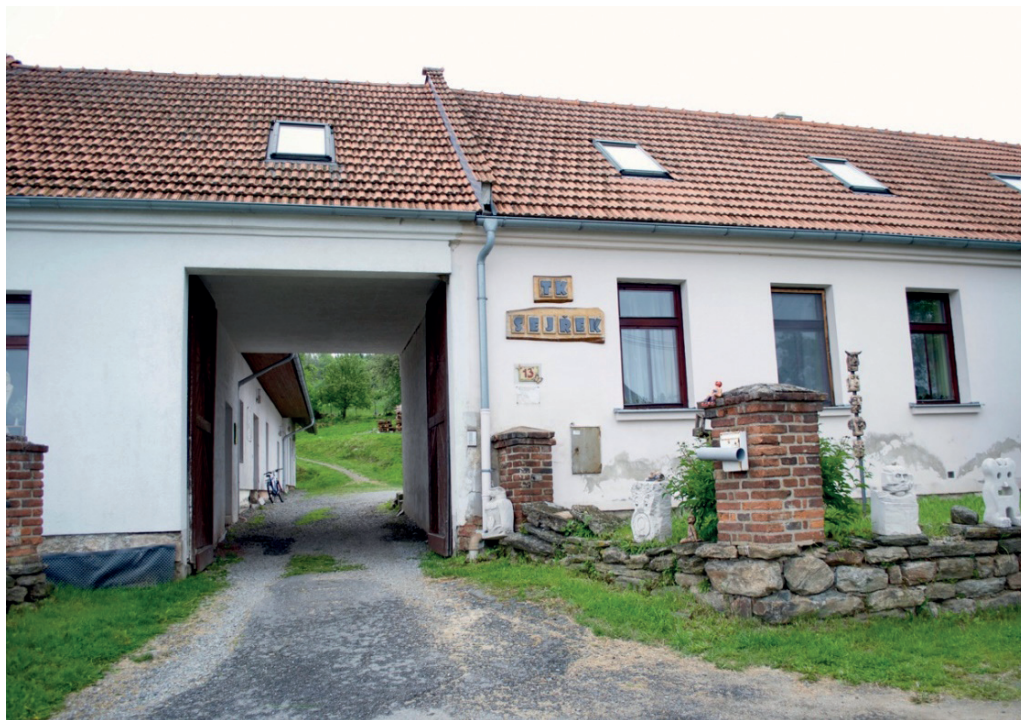
Obr. 7 Vstup do TK Sejřek (zdroj: vlastní zpracování).
