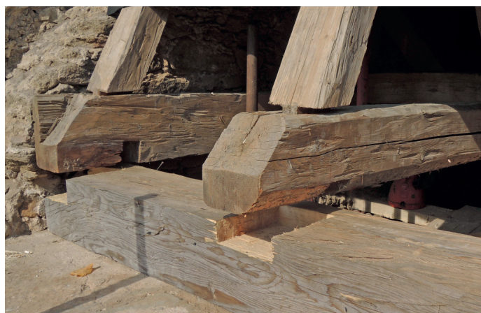
Obr. 2.5: Nově vložená pozednice v celé délce při konstrukční sanaci krovu kostela Božího Těla ve Slavonicích
