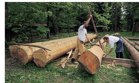
Obr. 5.4.1 Navalování a kotvení kulatiny na podvalech
