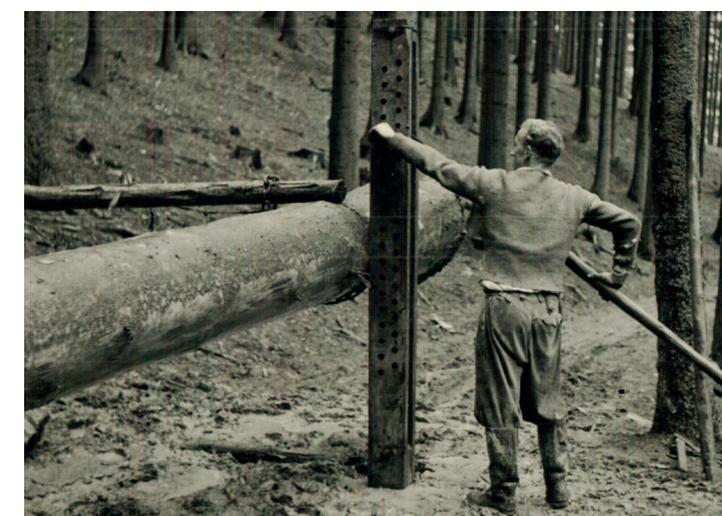
Obr. 5.2.6: Zvedání kmene pomocí pákového heveru (Zahradník, 1955)
