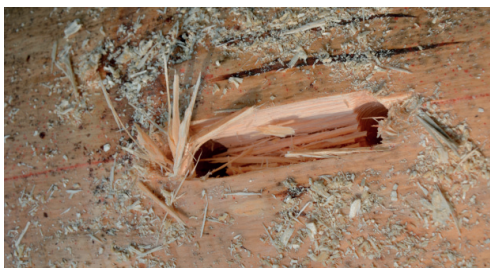
Obr. 5.4.7 Vydlabané lůžko pro vkládání klínu
