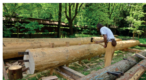
Obr. 5.4.14 Dokončování štípání v místě druhého čela
