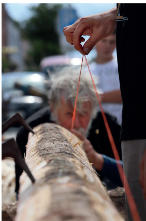
Obr. 5.3.8: Korekce svislosti napnuté šňůry při značení
