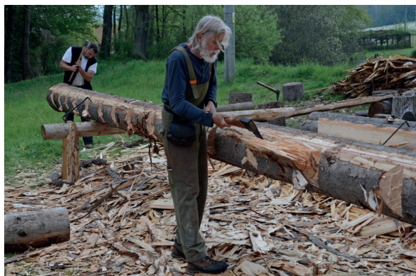
Obr. 5.3.14: Párové hrubování, kdy tesaři každý z jedné strany kulatiny jdou ve stejném směru (pravák a levák)
