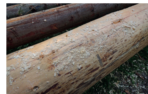
Obr. 5.4.6 Vyvrty pro dlaby a jejich rozmístění na vyznačené lince
