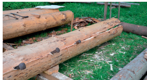
Obr. 5.4.10 Zarážení kovových klínů v místě vyznačené rysky za účelem iniciace štěpné spáry
