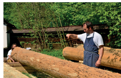
Obr. 5.4.19 Značení linky za účelem osekání vnitřní plochy půlkulaté srubnice
