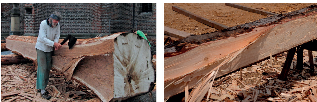
Obr. 5.3.23: Visící soudržné oštěpky při lícování
