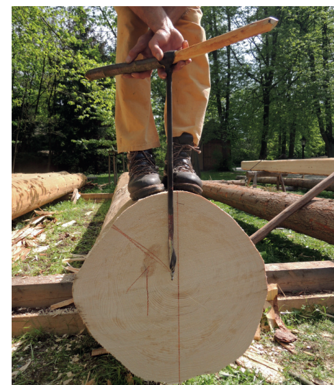
Obr. 5.4.3 Rozměření dělicí rysky umístěné v místě dřevě
