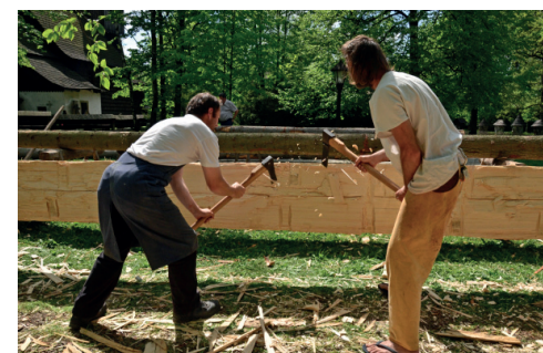
Obr. 5.4.20 Vrubování vnitřní plochy půlkulaté srubnice
