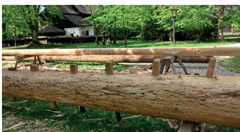
Obr. 5.4.13 Zarážení dřevěných klínů do štěpné spáry
