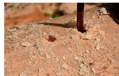
Obr. 5.4.5 Vyvrtné otvory pro vedení dlabu
