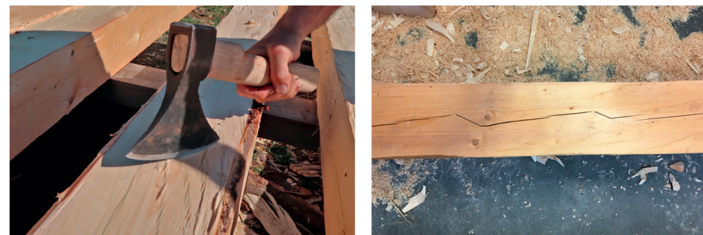
Obr. 6.9: Příčné poseky sekou A – zásek sekou do plochy čerstvě opracovaného trámu, B – přerušované výsušné trhliny vlivem poseků sekou
