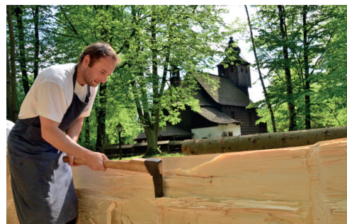
Obr. 5.4.22 Hrubování vnitřní plochy půlkulaté srubnice
