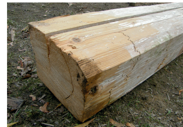
Obr. 3.14: Přetržení vláken na tahové straně obýbaného trámu způsobené odlupčivou trhlinou
