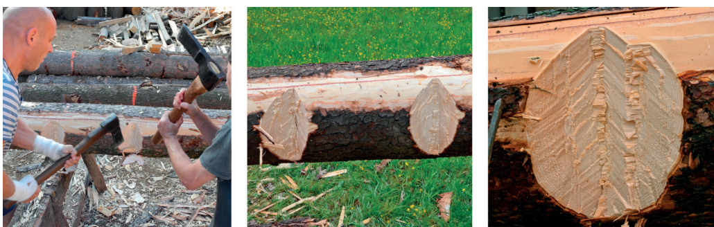
Obr. 5.3.10: Párové vrubování A – celkový pohled na vrubování v páru, B – vytínané vruby v oblině kulatiny blíží se k vyznačené lince, C – detail vrubu po párovém vrubování
