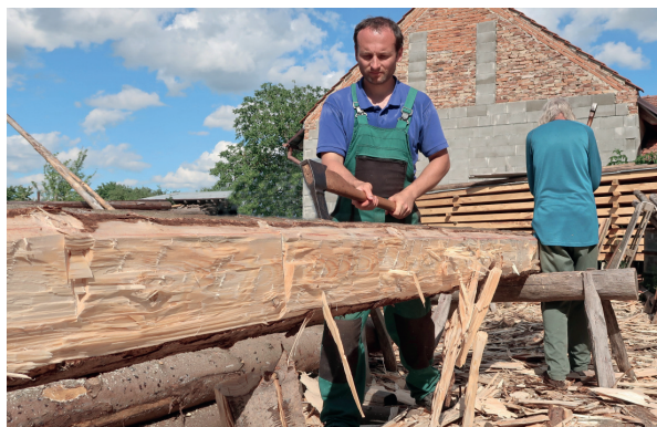
Obr. 5.3.13: Párové hrubování, kdy tesaři každý z jedné strany kulatiny jdou proti sobě (pravák a pravák)
