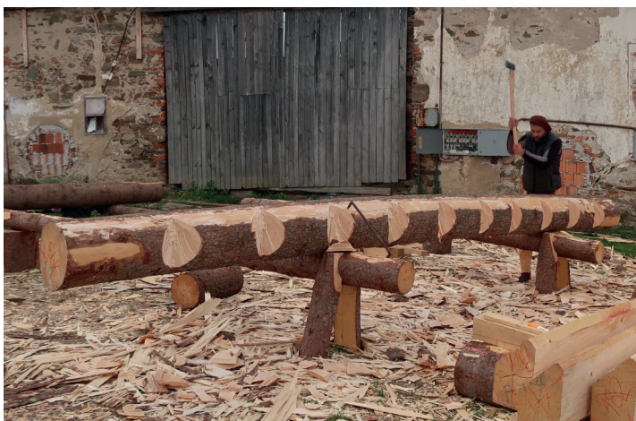
Obr. 5.2.7: Usazení kulatiny kobyly navrch
