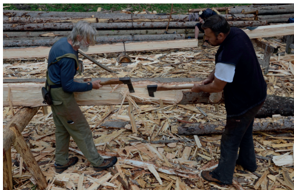
Obr. 5.3.15: Párové hrubování, kdy tesaři pracují na jednom úseku společně a pravidelně se střídají
