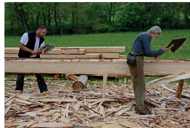
Obr. 5.3.20: Práce praváka a leváka při lícování na jednom prvku
