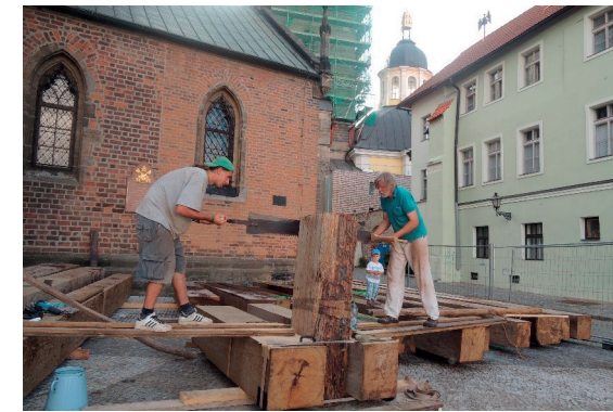
Obr. 5.5.4 Podélné řezání svisle upevněného prvku
