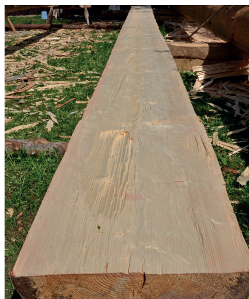
Obr. 5.4.24 Vnitřní plocha půlkulaté srubnice po dokončení
