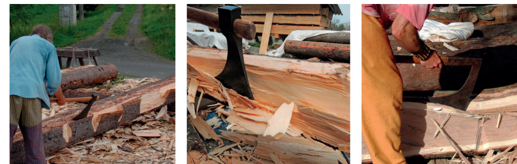
Obr. 5.3.26: Tesání kulatiny nízkou prací A – tesání sekerou na dlouhém toporu, B – detail sekery na dlouhém toporu, C – tesání sekerou na krátkém topůrku
