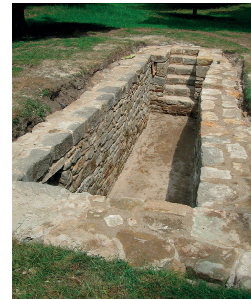
Obr. 5.5.5 Pilnice (jáma) pro podélné řezání
