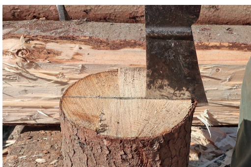
Obr. 5.4.28 Napažení čela v zamýšlené linii rozštěpu
