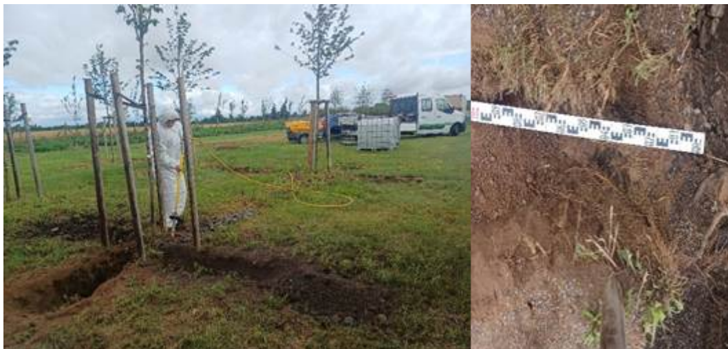
Obr. 2: Výsadba stromů a zřizování kořenových cest
