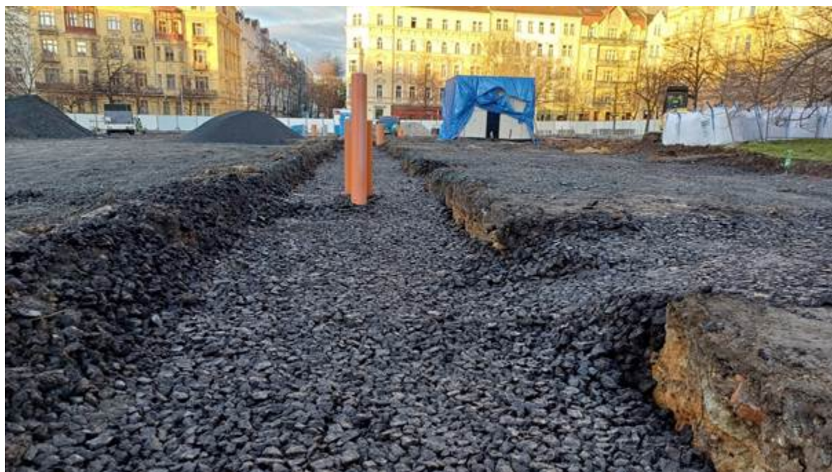
Obr. 26: Průběžné hutnění strukturálního substrátu ukládaného do rýhy.
